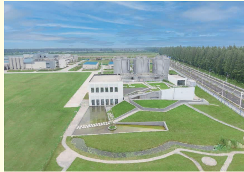
武汉工厂污水处理中心
